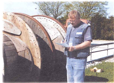
Die Monteure verlegten insgesamt 80 t Kabel. Bilder: SAG
